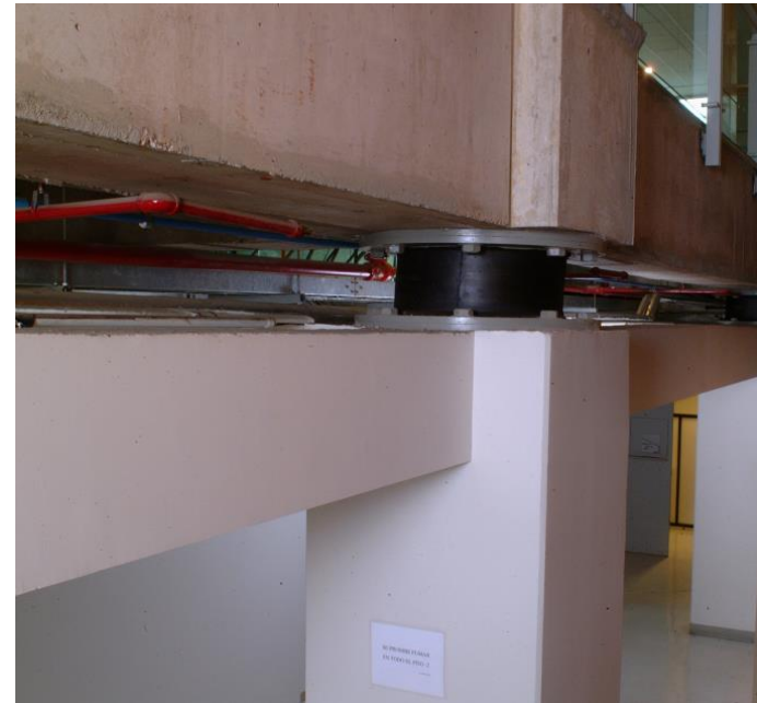
AISLADOR SISMICO
